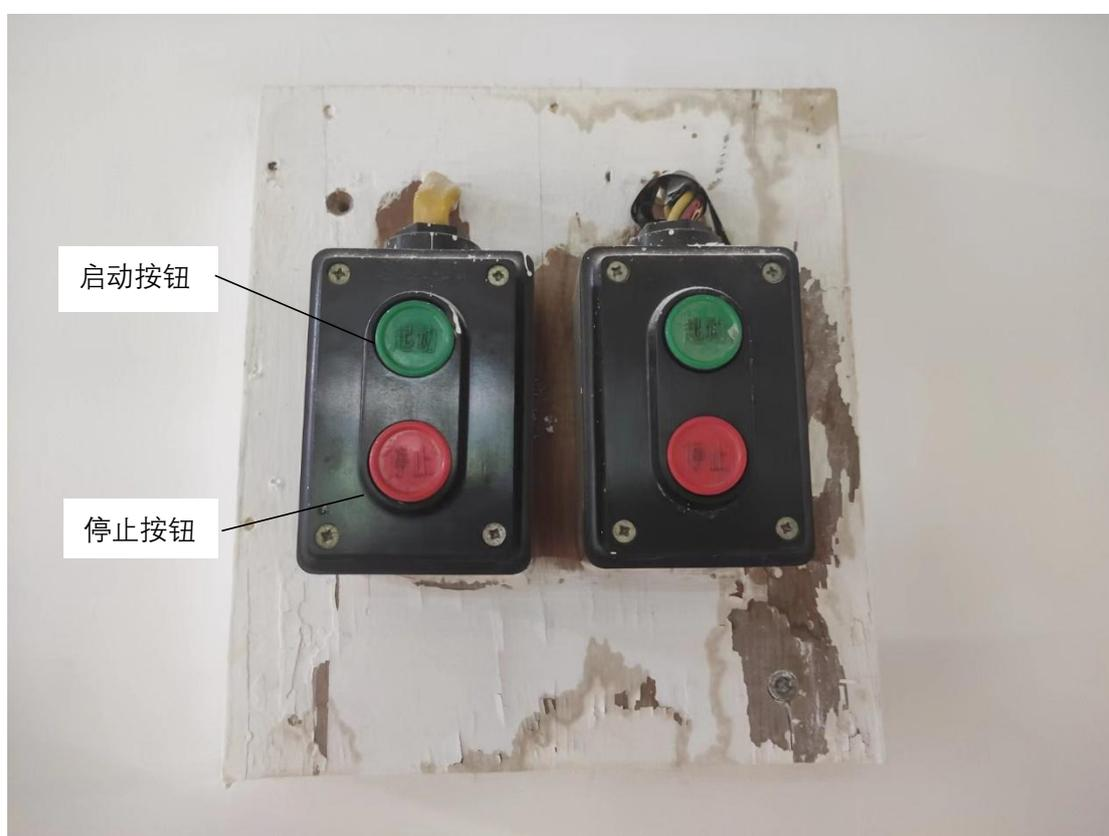
2.实验室通风橱开机后会把通风橱内空气送往屋顶夹层，然后再由总通风送往楼顶大气中。同学们在使用通风橱时，一定要注意要**同时打开通风橱开关和总通风开关**。
